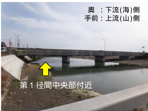
写真 - 2 B橋外観写真
