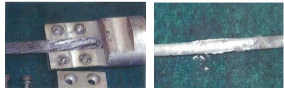
【把持金具部分の腐食】 【アルミパイプの腐食・膨張】
