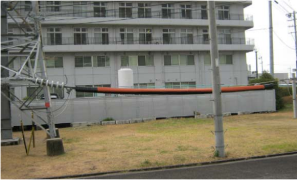
図 14 模擬電線への取付状況
