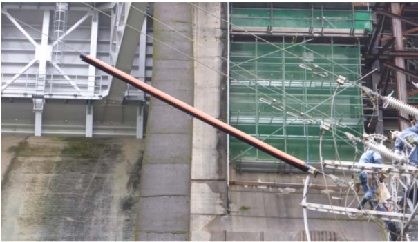
図 15 実送電線への設置状況
