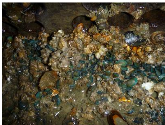
図1 海水取水設備への生物付着状況
