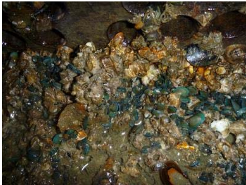
図1 海水取水設備への生物付着状況
