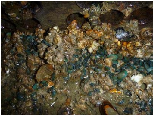
図1 海水取水設備への生物付着状況
