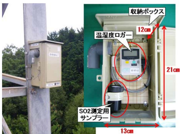
図6 鉄塔での環境データ観測状況
