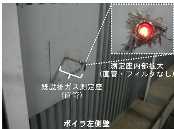
図1 ボイラ左側壁既設排ガス測定座
