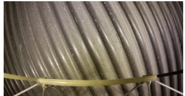
図6 ボイラ炉底チューブ
