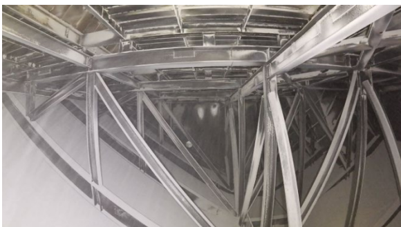
図 8 ボイラ後部煙道下部
