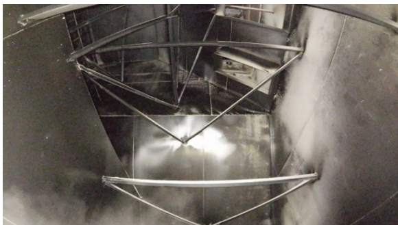
図 7 ボイラ後部煙道内の梁
