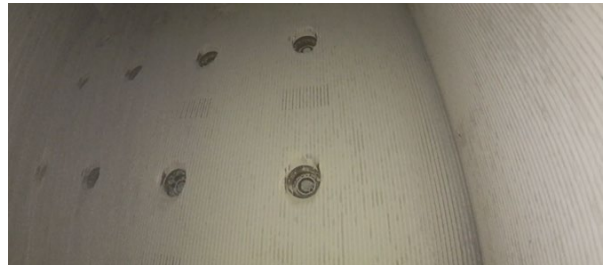
図5 ボイラバーナー部
