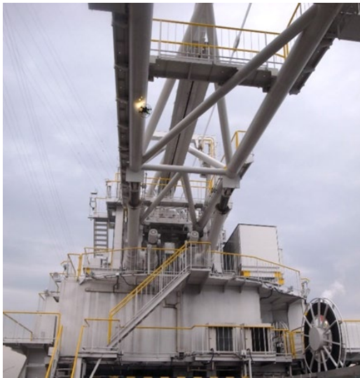
図 12 揚炭機ブーム点検状況
