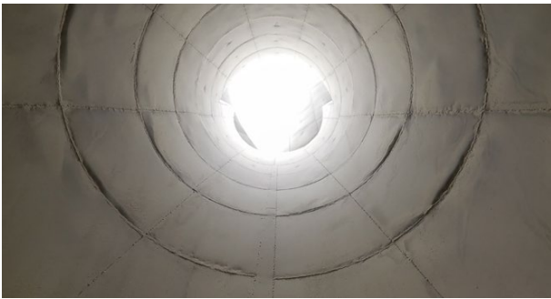
図2 煙突頂上部の内面
