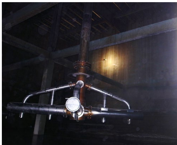
図 9 脱硫吸収塔内部点検状況
