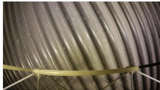
図4 ボイラ炉底チューブ
