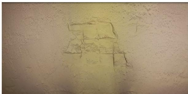
図3 煙突内面ライニングの劣化部位
