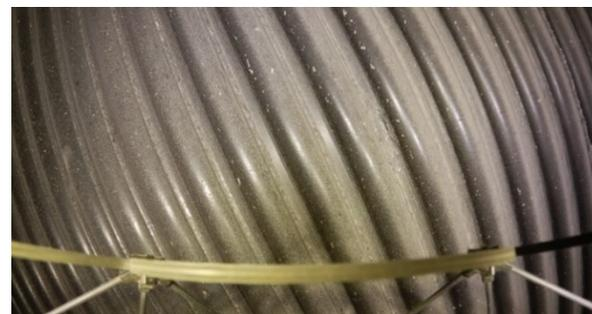
図6 ボイラ炉底チューブ
