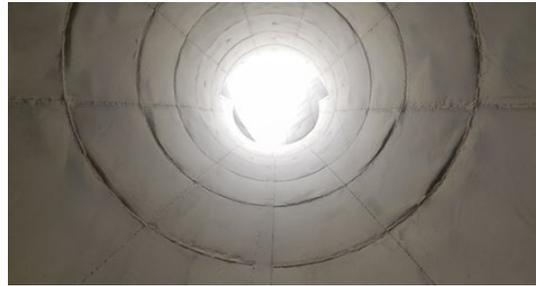
図2 煙突頂上部の内面
