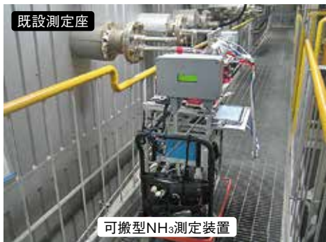
移動測定状況
