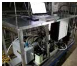
測定制御部設置状況
