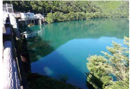
現地調査状況(貯水池)
