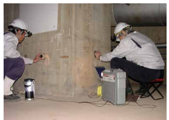
超音波法によるコンクリート診断
