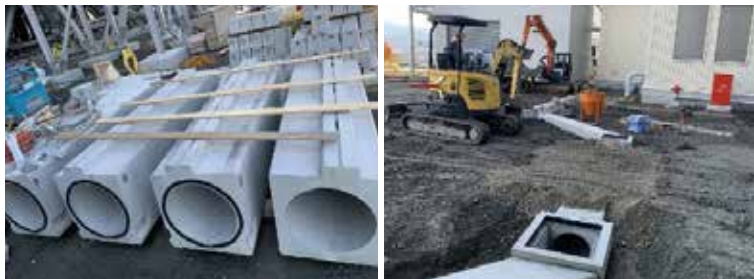
西条発電所構内工事にFA入りコンクリート2次製品を導入
