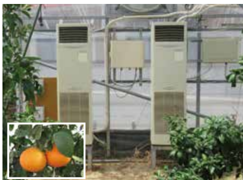
柑橘類へのヒートポンプ適用試験
