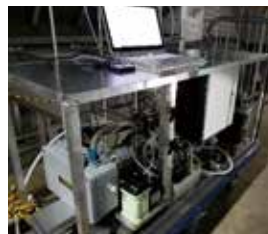
測定制御部設置状況
