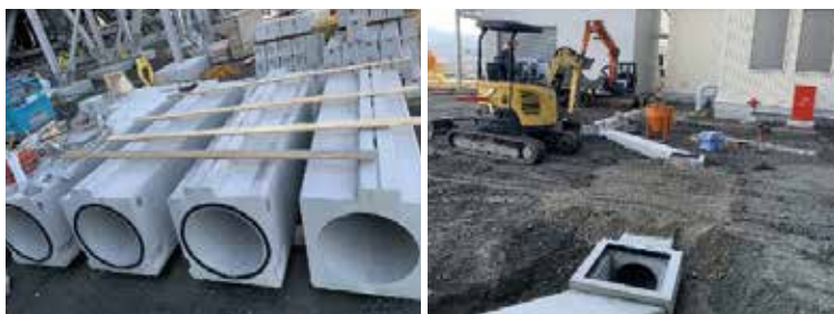
西条発電所構内工事にFA入りコンクリート2次製品を導入
