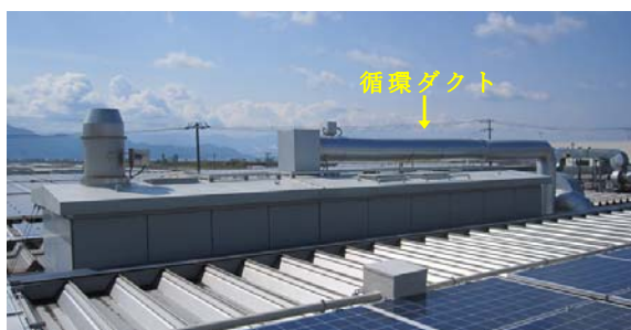
写真3 改造後の大気保全設備 (全景)
