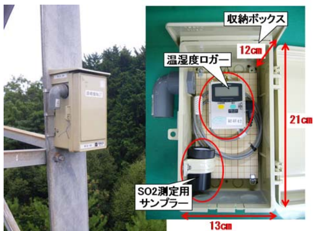
図6 鉄塔での環境データ観測状況
