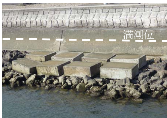
写真-1 屋外暴露試験状況(干満帯)
