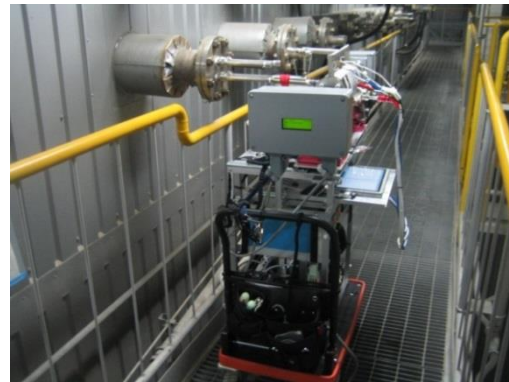
図4 脱硝出口での移動測定試験状況
