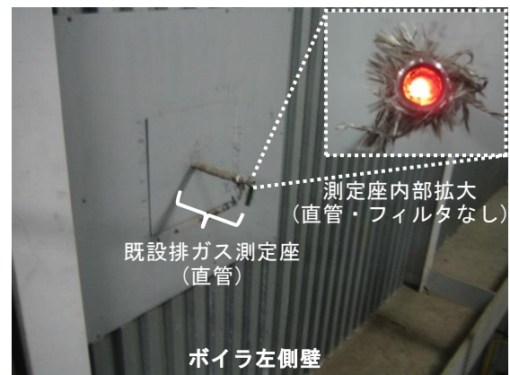
図1 ボイラ左側壁既設排ガス測定座
