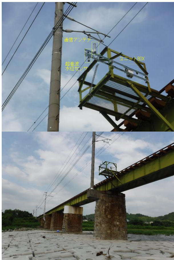
図-4 センサユニットの設置状況
