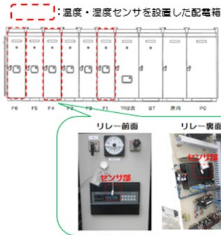
図1 配電箱内温度・湿度センサ取付状況
