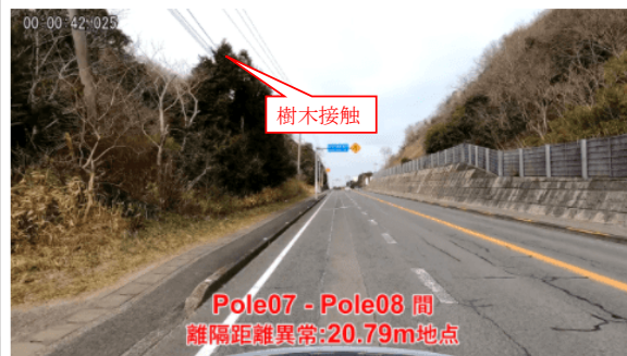
離隔距離異常発生箇所 (写真)
