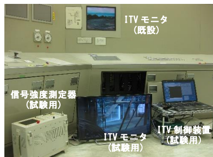
(b) 試験状況(制御室側)
