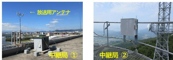
図4 中継局(放送局)の設置状況
