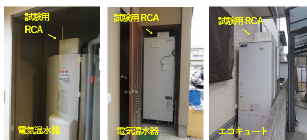
図5 電気給湯器への試験用 RCA 設置状況
