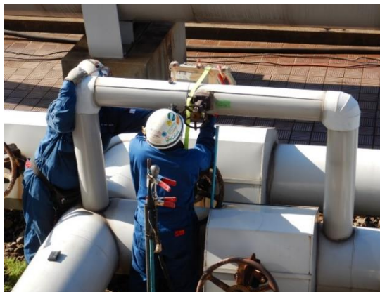
図 12 フラットパネル設置作業実施状況
