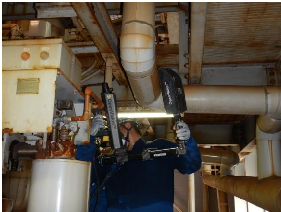
図4 CUI-Visionによる撮影作業状況
