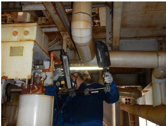
図4 CUI-Visionによる撮影作業状況
