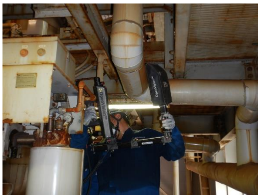
図3 CUI-Vision による撮影作業状況
