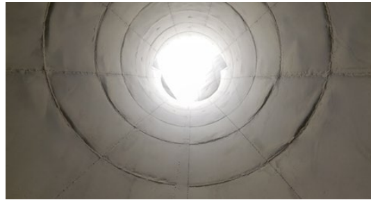
図 2 煙突頂上部の内面
