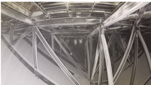
図 5 ボイラ後部煙道下部
