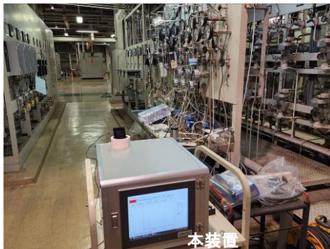
(b) 本装置設置状況 図 12 現地試験状況
