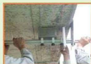
① PCU桁における 着磁状況 (磁石ユニットを用いて)
