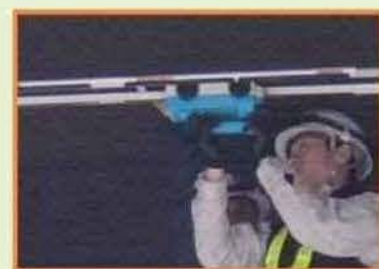
② プレテンション桁における 磁束密度測定状況 (磁気計測ユニットを用いて)
