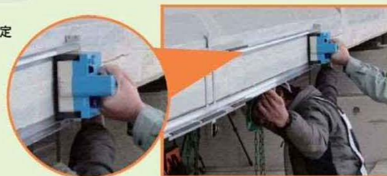
② PCT桁における 磁束密度測定状況 (磁気計測ユニットを用いて)
