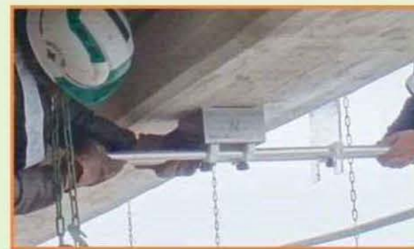
① PCT桁における 着磁状況 (磁石ユニットを用いて)
