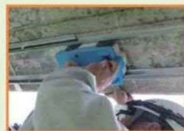
② PCU桁における 磁束密度測定状況 (磁気計測ユニットを用いて)
