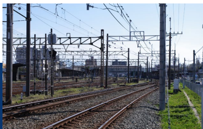
鉄道架線柱の点検 | 鉄道インフラの維持
